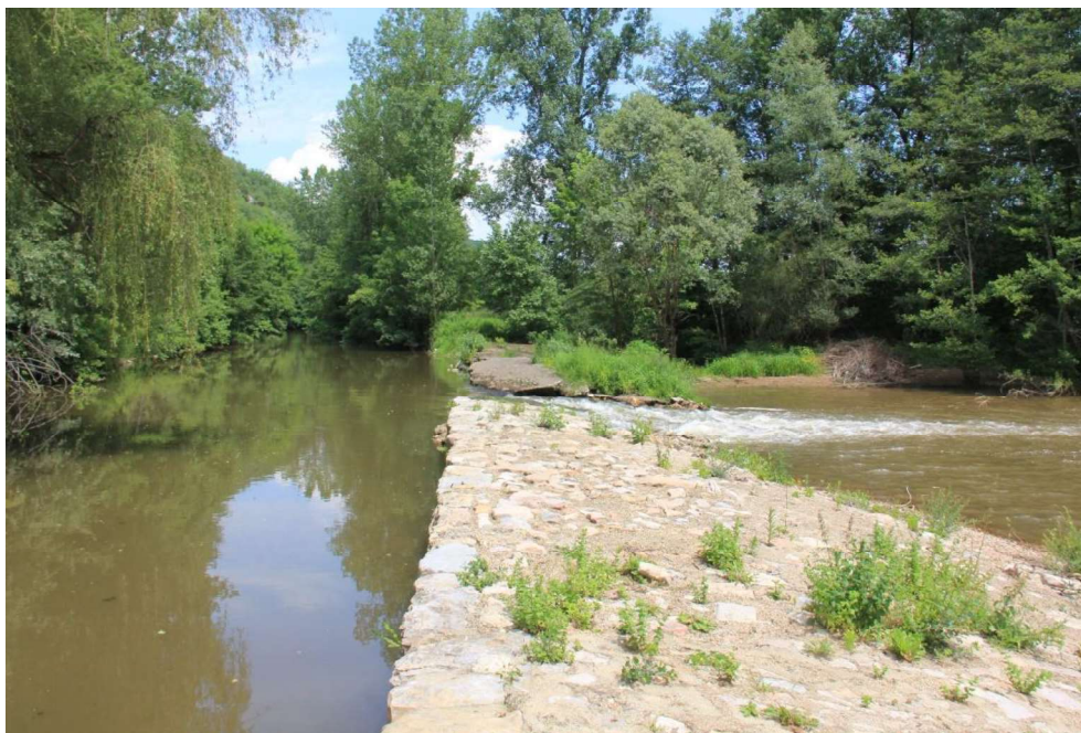
Figure 4 Illustration du seuil et de la brèche – vue vers l'amont
