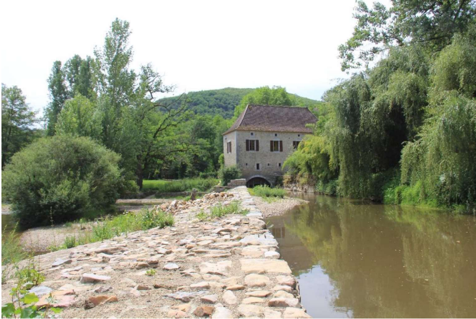
Figure 5 Illustration du seuil et du bâtiment-moulin – vue vers l'aval
