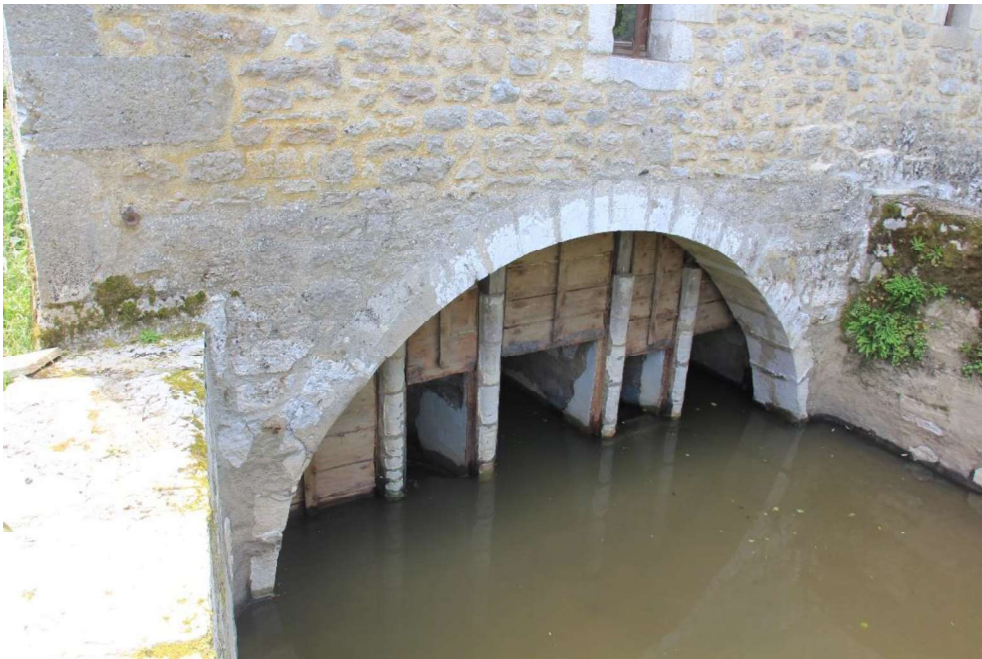
Figure 6 Illustration de l'entrée d'eau du moulin
