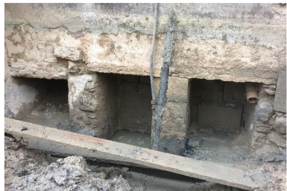
Entrées d'eau du moulin
