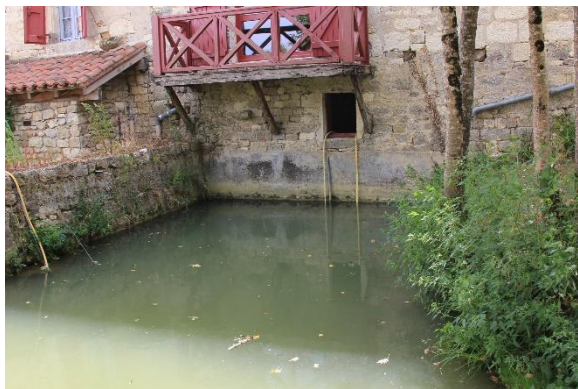
Face amont du moulin
