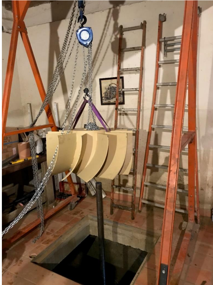
Figure 22 Installation d'une copie de rouet en acier sur son arbre (source : « blacour », Forum de la petite hydroélectricité)
