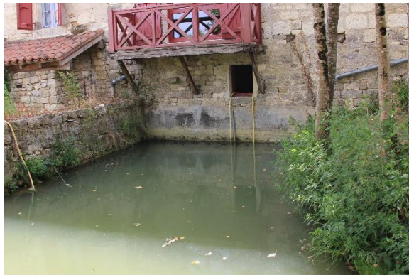
Face amont du moulin
