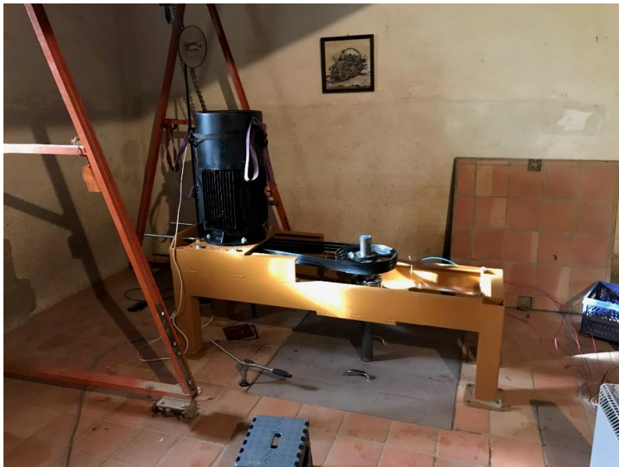
Figure 23 Système poulie-courroie et générateur de l'ordre de quelques kW (source : « blacour », Forum de la petite hydroélectricité)
