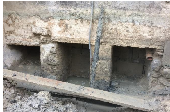
Entrées d'eau du moulin
