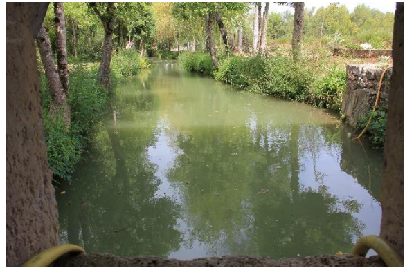
Canal de dérivation vu depuis le moulin
